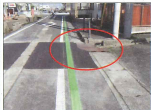
段差が解消 グリーンベルトを設置
