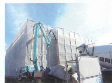
ポンプ車によるコンクリート打設状況
